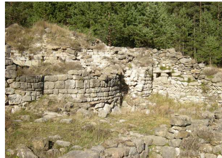
Sala anexa a la iglesia. En la pared se ven dos hileras de losas inclinadas puestas en forma de espiga que es un tipo de construcción empleado en las construcciones románicas
