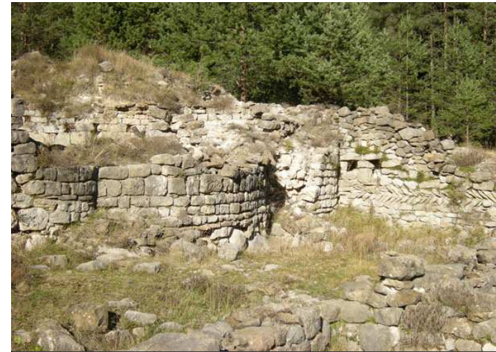
Sala annexa a l'església. A la paret es veuen dues fileres de lloses inclinades posades en forma d'espiga que és un tipus de construcció emprat a les construccions romàniques
